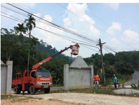
๙. โครงการปรับปรุงซ่อมแซมไฟฟ้าสาธารณะในเขต อบต.เกียร์
